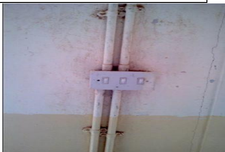
شكل (b-3-6) يوضح الخدمات الكهربائية الظاهرة في بناية قسم الهندسة
