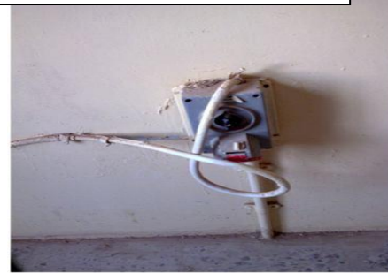
شكل (b-3-6) يوضح الخدمات الكهربائية الظاهرة في بناية قسم الهندسة
