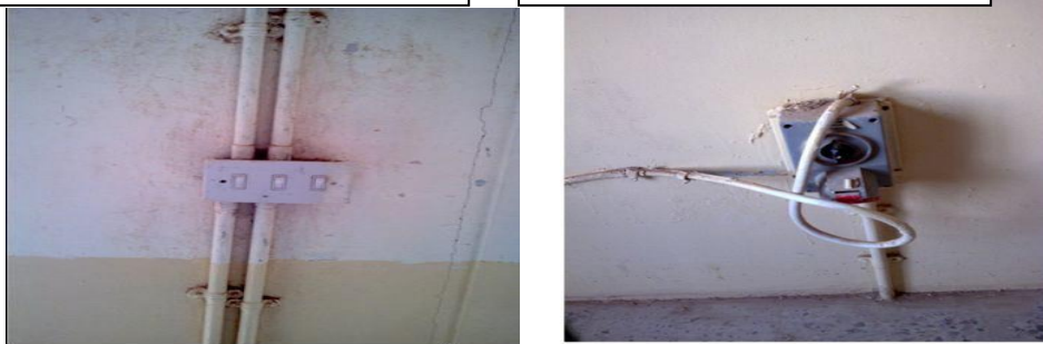
شكل (b-3-6) يوضح الخدمات الكهربائية الظاهرة في بناية قسم الهندسة
