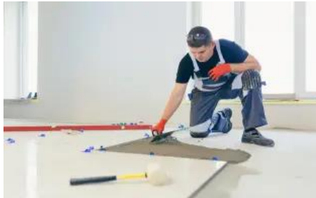
شكل (3) تشطيب أرضية المبني باستخدام البلاط.
