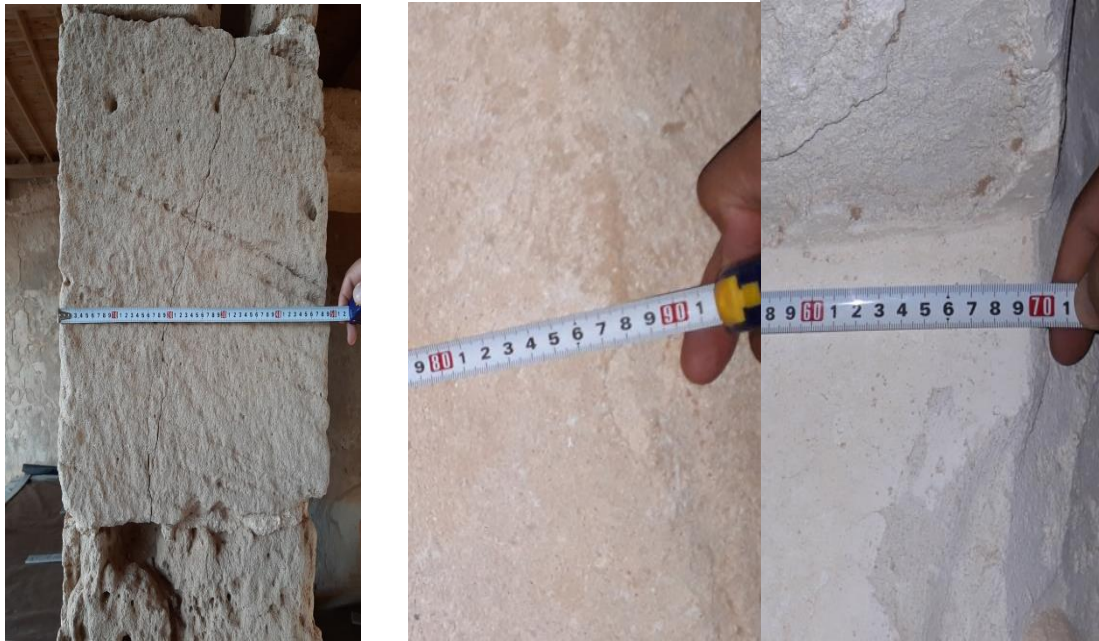
شكل (4) سمك الحوائط الداخلية [9]
